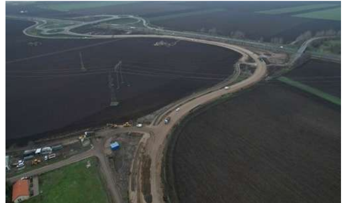
A képen Józsaát az autópályafelhajtóval összekötő út építése látható
