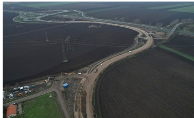
A képen Józsat az autópályafelhajtóval összekötő út építése látható
